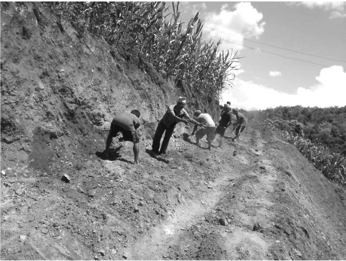
सक्रियता : काभ्रेको मण्डनदेउपुर नगरपालिका-११ का स्थानीयबासी कुटो कोदालोको भरमा गाउँमा सडक खन्दै। यस गाउँमा पछिल्ला दिनमा स्थानीयबासी विकास निर्माणमा सक्रिय रहँदै आएका छन्। तस्वीर : ज्ञानमणि नेपाल कालोटोपी/काभ्रे
